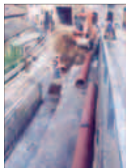
La posa di tubi fognari
