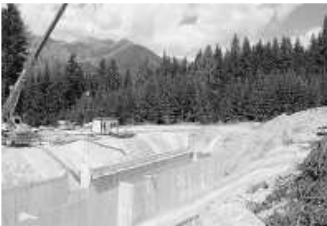
Il cantiere dell'impianto sciistico "Pinzolo - Campiglio"
